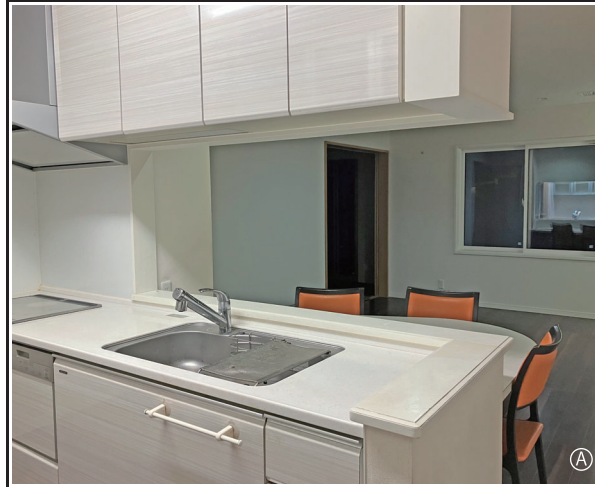
改修前: ④ ビニルクロス、化粧フィルムなどを基調とした仕上の空間
